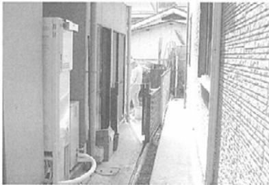
工事中的エコ・ウィル 左の貯湯タンクと右のエンジン
