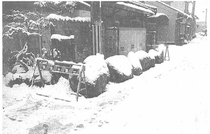
掘り出した石垣の石
